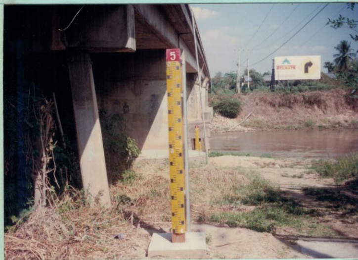
เสาคอนกรีตที่ 5 7.00-9.00 ม.
