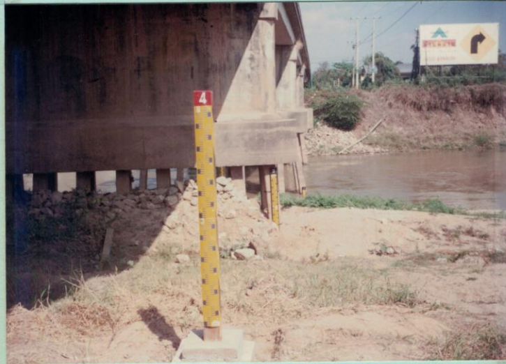
เสาคอนกรีตที่ 4 5.00-7.00 ม.
