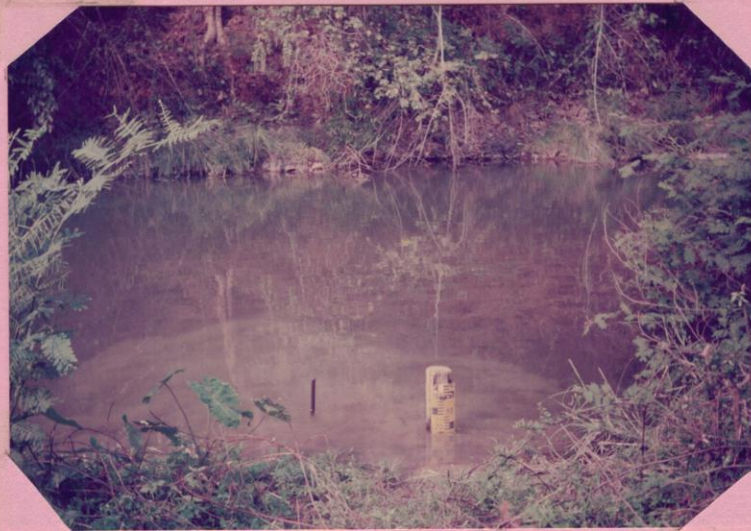
รูปถ่าย เสาระดับน้ำคันที่ 1 (0.00-1.00 ม.) คันในน้ำซึ่งเป็นเสาไม้เนื้อแข็ง \phi 6" มีสภาพผุและไม้แข็งแรง
