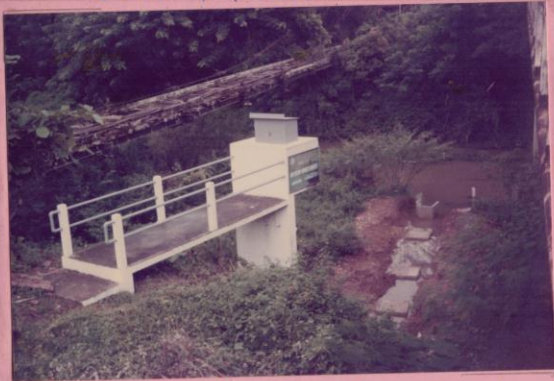
รูปที่ ๑๖ สะพานคอนกรีตข้ามลำน้ำฝาย การระบายน้ำ (ลึก ๑ เมตร) (Y.13) ณ. ๕๗๓ จ. สิงห์บุรี
