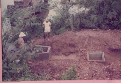
รูปที่ ๑๕ การก่อสร้างท่อระบายน้ำ MANHOLE (ลึก ๑ เมตร) (Y.13) ณ. ๕๗๓ จ. สิงห์บุรี
