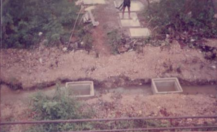
รูปที่ ๑๕ การก่อสร้างท่อระบายน้ำ MANHOLE (ลึก ๑ เมตร) (Y.13) ณ. ๕๗๓ จ. สิงห์บุรี
