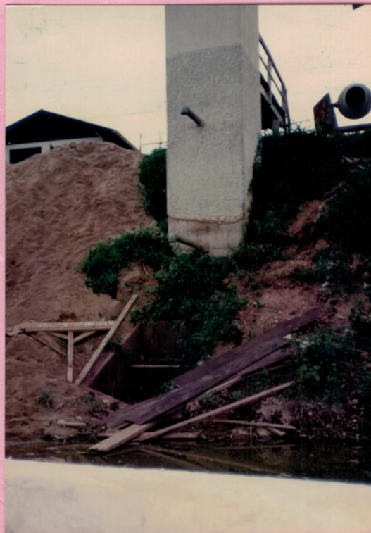
ปากท่อนอนตัวล่างที่จะขอให้ทางผู้รับเหมาก่อสร้าง ต่อท่อนอนขึ้นออกมาให้พ้นแนว SLOPE ของตลิ่ง เพื่อให้สามารถรับน้ำได้
