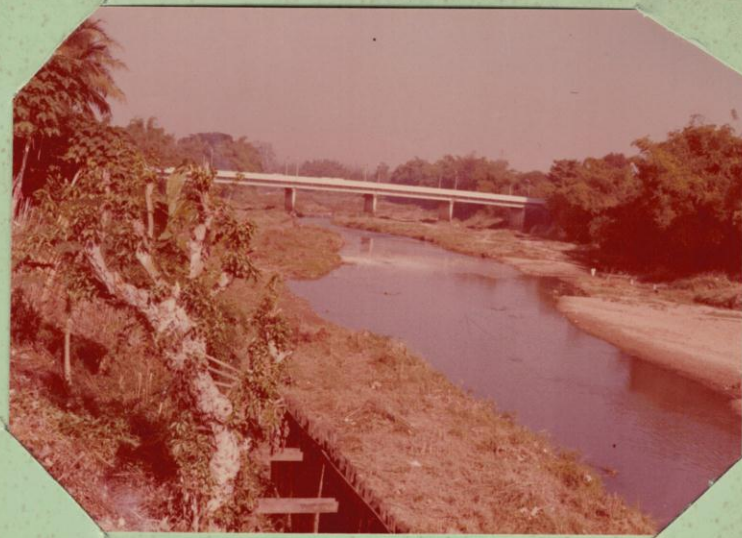
สถานีลำน้ำ ท้าย สถานีวัดน้ำ W. 1A แม่น้ำวัง
