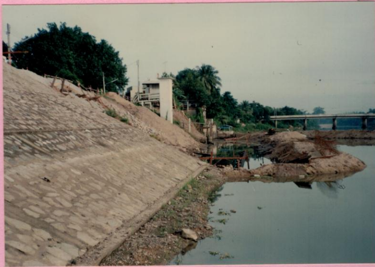
แสดงการปิดกั้นลำน้ำบริเวณอาคารสถานีวัดระดับน้ำอัตโนมัติ W. 1A เพื่อเตรียมการก่อสร้างเขื่อนกริตต์แต่งตลิ่ง.
