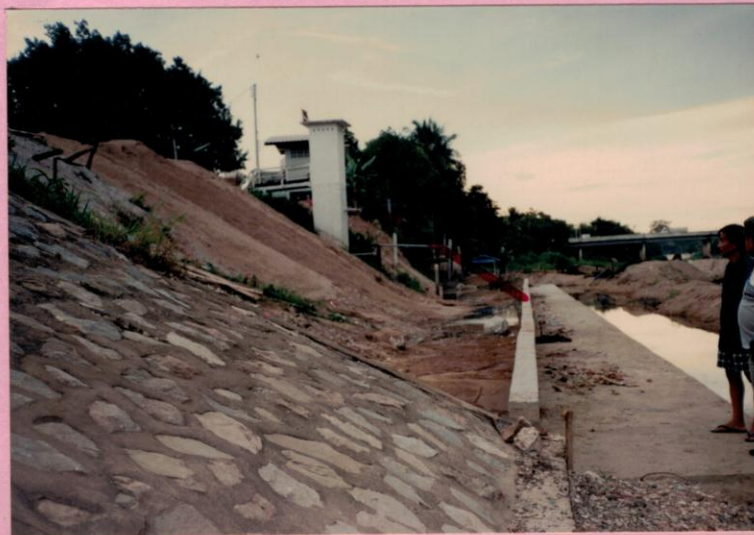
เมื่อเทพราชและปูนตาม SLOPE. ต่อจากตลิ่งที่ทำไว้เดิมจะถมเสา- ระดับมิตทุกต้นรวมทั้งปากท่อนอนทุกตัวด้วย.
