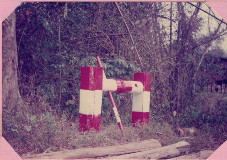
รูปถ่าย โครงงานสลิงโยงเรือสำรวจ หลังจากซ่อมแซมเรียบร้อยแล้ว
