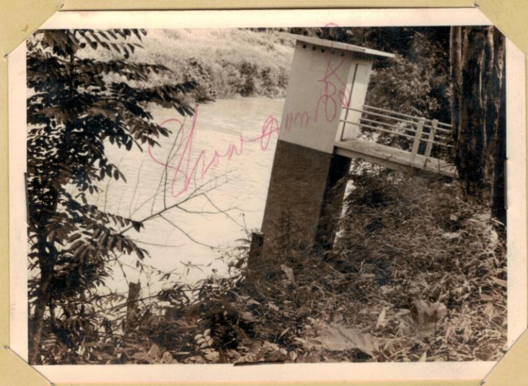
รูปด้านข้างของสถานีวัดระดับน้ำอัตโนมัติ W16
