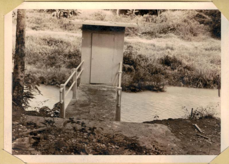
รูปด้านหน้า สถานีวัดระดับน้ำอัตโนมัติ W16
